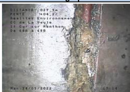
Concrétions avec suspicion d'infiltration - entre R68A et R68B
