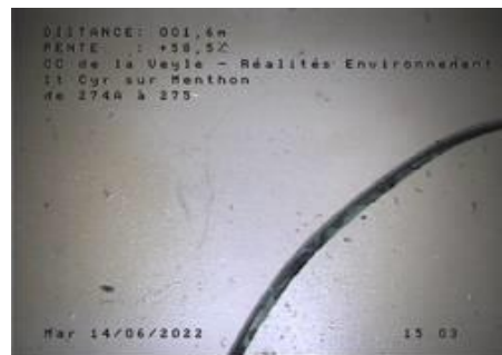
Fissure avec vide visible par le défaut- entre R274 et R273 Fissure avec vide visible par le défaut- entre R274A et R275
