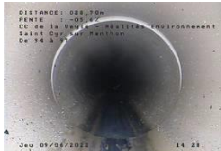
Plusieurs déplacement d'assemblage (4)- entre R94 et R97
