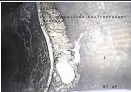
Changement de diamètre de canalisation
