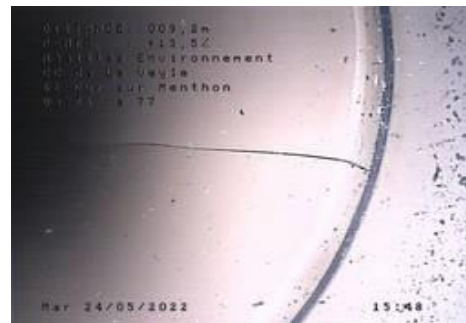
4 fissures de cette ampleur - entre R76 et R77
