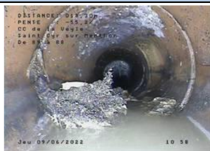
5 ensembles complexes de racines avec infiltration constatée entre R89 et R88
