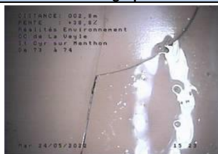
7 Fissures dont 3 avec infiltration constatée- entre R73 et R74
