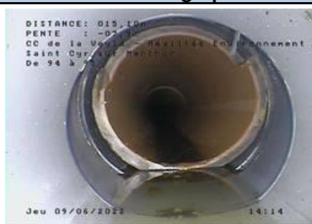
Double changement de matériaux sans regard de visite avec défaut et vide apparent à la jonction des canalisations Grès--> PVC--> Grès à deux mètres d'intervalle avec changement de diamètres. Entre R94 et
