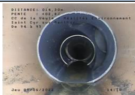
Double changement de matériaux sans regard de visite avec défaut et vide apparent à la jonction des canalisations Grès--> PVC--> Grès à deux mètres d'intervalle avec changement de diamètres. Entre R94 et
