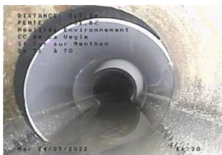
Double changement de matériaux sans regard de visite avec défaut et vide apparent à la jonction des canalisation Fonte--> PVC--> Fonte à un mètre d'intervalle. Entre R71 et R70
