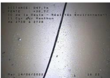
Fissure - entre R273A et R273B
