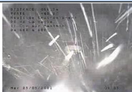
Ecoulement continu d'eau claire visible au cours de l'inspection-R 68C
