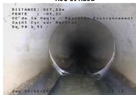
Déplacement d'assemblage créant possiblement une perte d'effluents- entre R94 et R93
