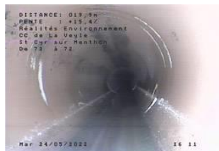
Fissures entre R73 et R72
