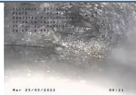
Dépôt adhérent avec possible présence de racines car complètement bouché - entre R68A et R68B
