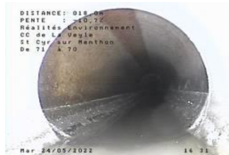
Double changement de matériaux sans regard de visite avec défaut et vide apparent à la jonction des canalisation Fonte--> PVC--> Fonte à un mètre d'intervalle. Entre R71 et R70
