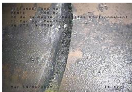
Fissure - entre R273A et R273
