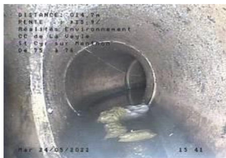
Raccordement défectueux - branchement en contre pente - entre R75 et R76
