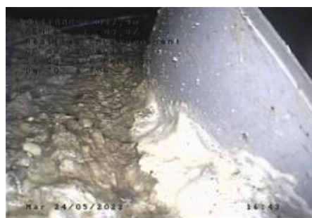
Infiltration constatée au droit du R70A
