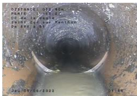
Déplacement d'assemblage créant possiblement une perte d'effluents- entre R89B et R89A
