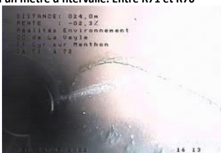
Double changement de matériaux sans regard de visite avec défaut et vide apparent à la jonction des canalisation Fonte--> PVC--> Fonte à un mètre d'intervalle. Entre R71 et R70
