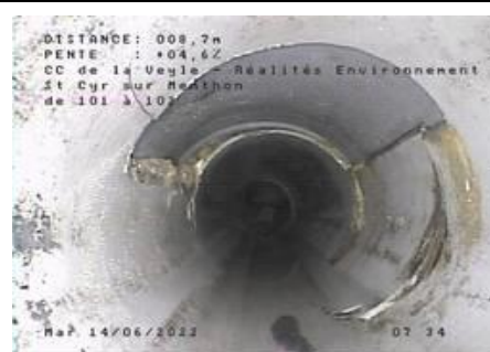
Rupture avec réparation ponctuelle - entre R101 et R102
