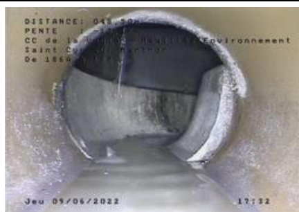
Goutte à goutte constaté à l'arrivée dans le regard R185
