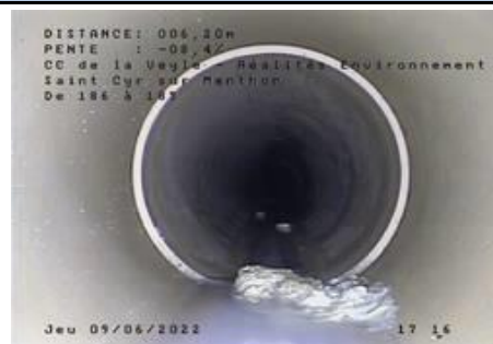
Déplacement d'assemblage - entre R186 et R186A
