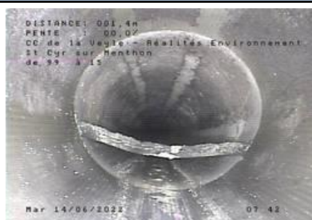
Joint d'étanchéité apparent et empêchant l'inspection - entre R99 et
