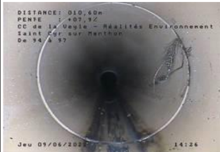
Double changement de matériaux sans regard de visite avec défaut et vide apparent à la jonction des canalisations Grès--> PVC--> Grès à deux mètres d'intervalle avec changement de diamètres. Entre R94 et
