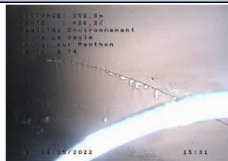
7 Fissures dont 3 avec infiltration constatée- entre R73 et R74
