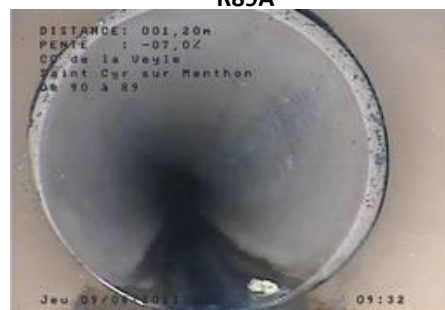
Multiple déplacement d'assemblage - entre R90 et R89B
