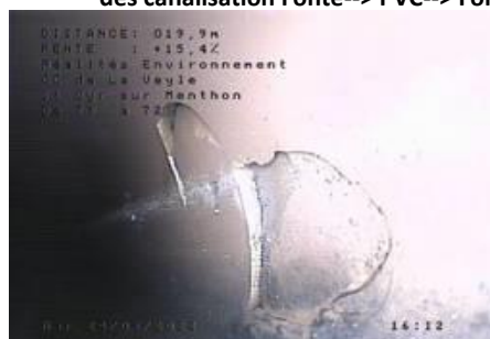
Double changement de matériaux sans regard de visite avec défaut et vide apparent à la jonction des canalisation Fonte--> PVC--> Fonte à un mètre d'intervalle. Entre R71 et R70
