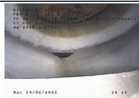
Dégradation de surface au droit du regard R273B
