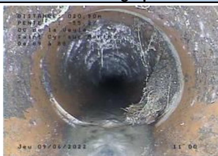
5 ensembles complexes de racines avec infiltration constatée entre R89 et R88
