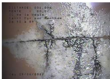
Fissure avec infiltration - entre R90 et R89B
