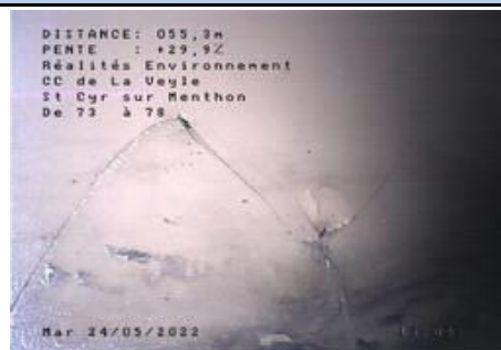
Une quinzaines de fissures de cette ampleur - entre R73 et R78
