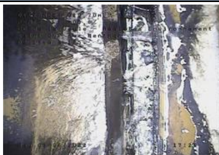
Infiltration constatée - entre R186A et R185
